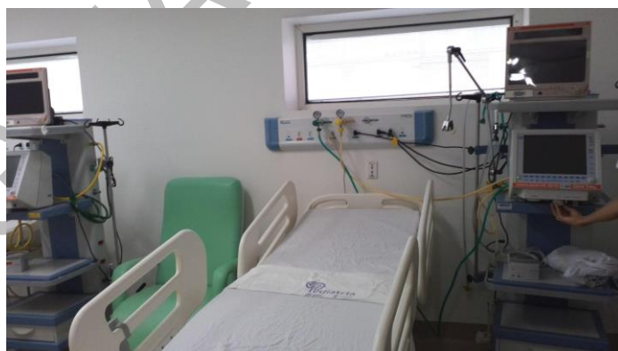
6.48. Unidade Semi Intensiva Pediátrica
